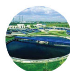
Очистка сточных вод
